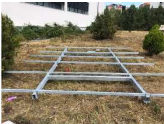
Figura 4.35 Lidhja e profileve dhe ndërtimi i konstruksionit për mbajtjen e paneleve
