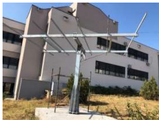
Figura 4.35 Lidhja e profileve dhe ndërtimi i konstruksionit për mbajtjen e paneleve
