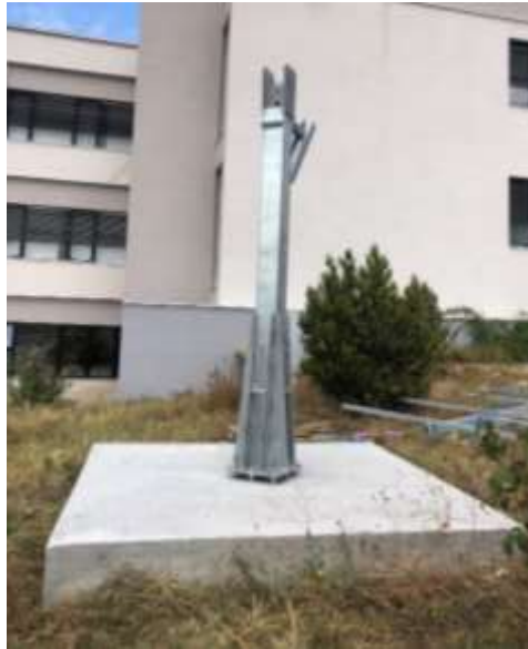
Figura 4.33 Shtylla kryesore vertikale e montuar mbi bazën e betonit
