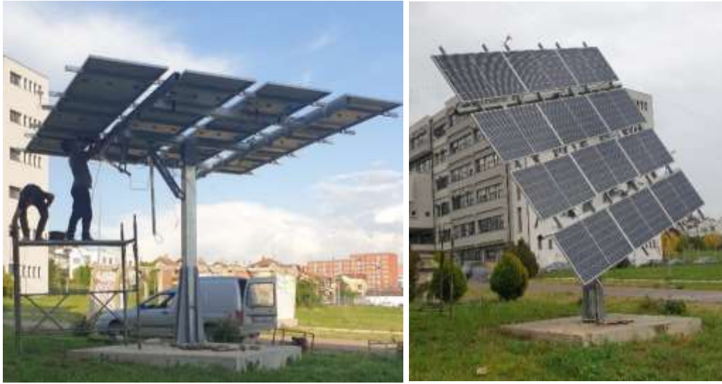
Figura 4.36 Montimi i paneleve solare dhe mekanizmi i kompletuar
