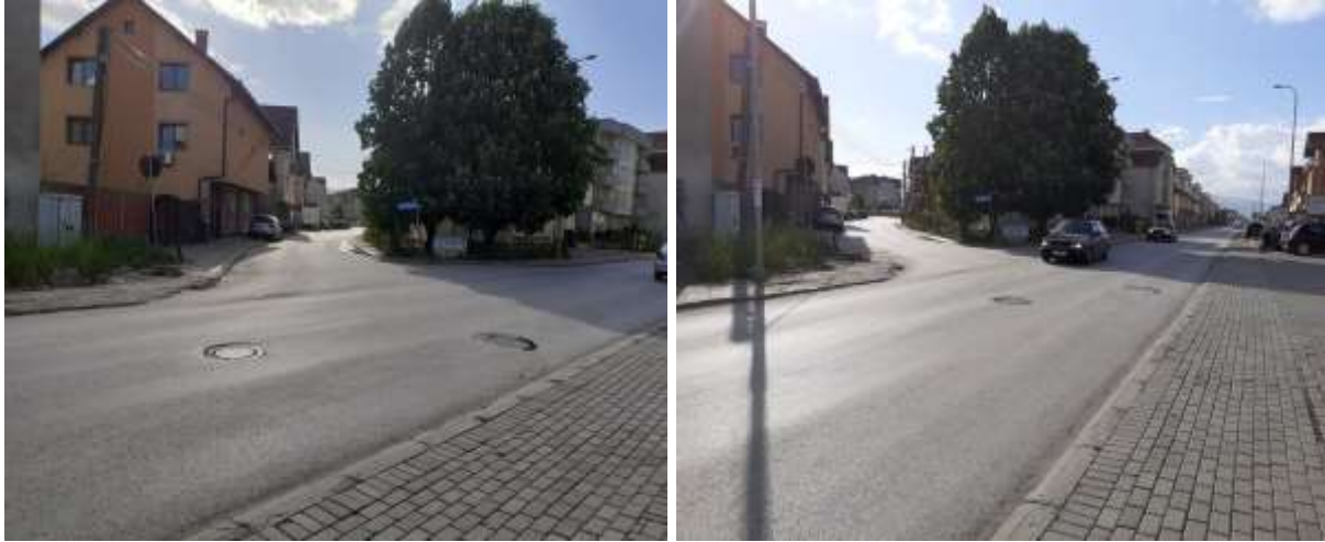
Figura 1.6: Pamja nga gjendja ekzistuese e udhëkryqit ne Rr. “Brigadat”
