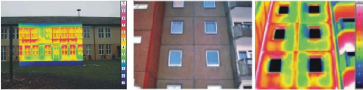
Figura 26. Pamje termografike të urave termike
