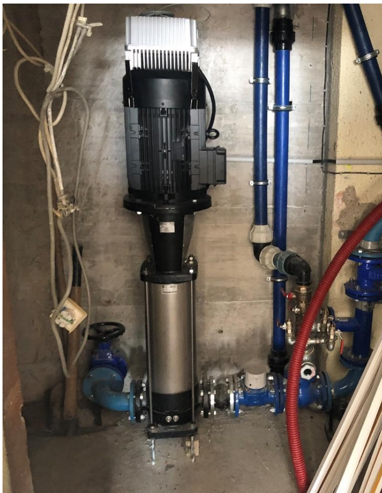
Figura 3.4.1. 1 Pompa centrifugale shumëshkallëshe
