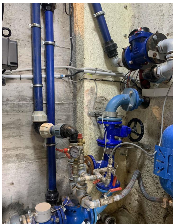
Figura 4.3. 3 Sistemimi i valvolave, ujëmatësit, enës ekspanduese
