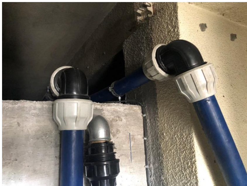
Figura 4.3. 5 Gypi furnizues, furnizimi nga ujësjellësi dhe gypi për largimin e ujit të tepërt
