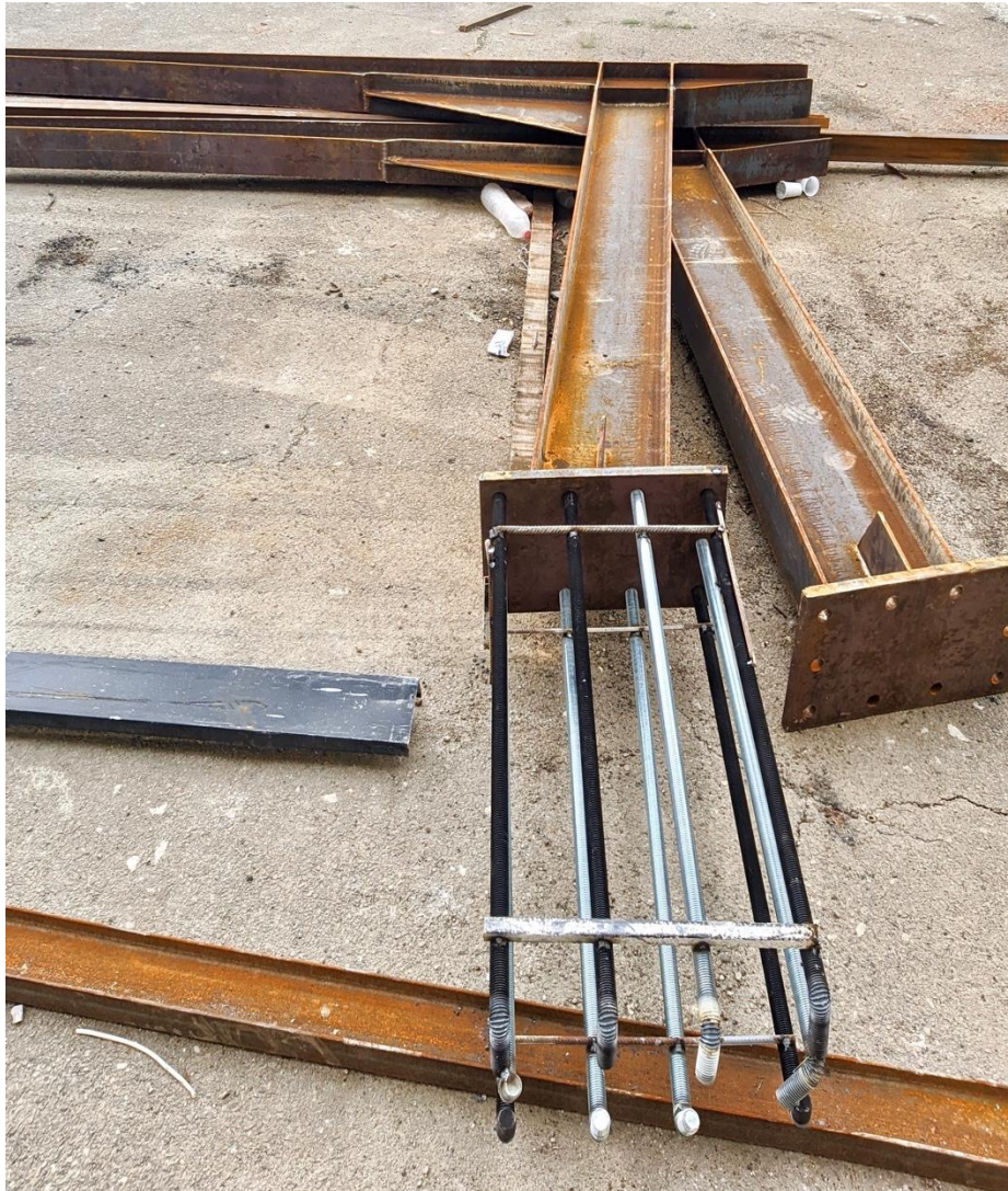
Figura 35. Lidhja e ankerave me profilin IPE 300.
