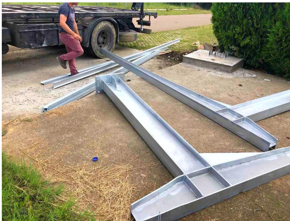
Figura 47. Pamje e profileve IPE para se të montohen.
