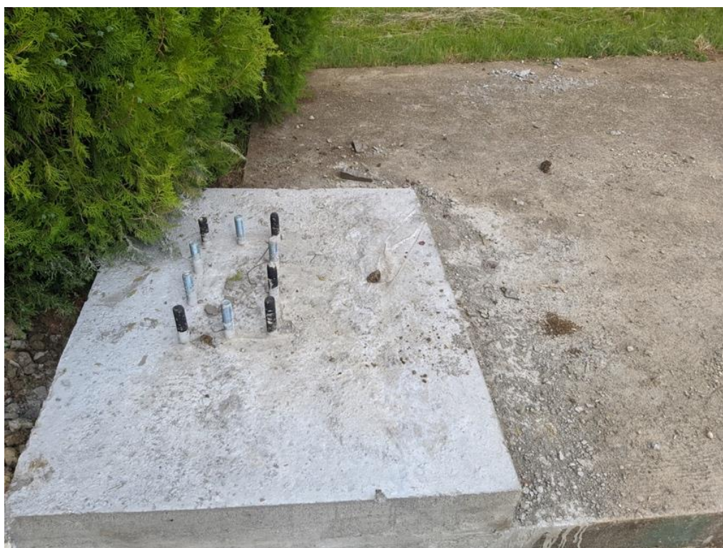
Figura 37. Ankerimi në beton.
