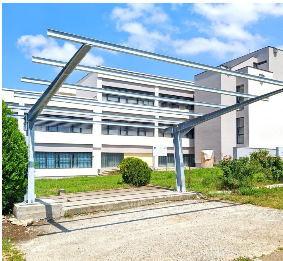
Figura 49. Pamje nga montimi i tërësishëm i konstruksionit metalik.
