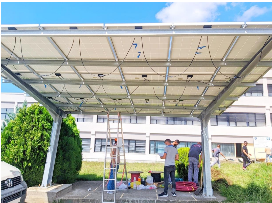
Figura 52. Pamje e lidhjeve serike në mes paneleve PV.
