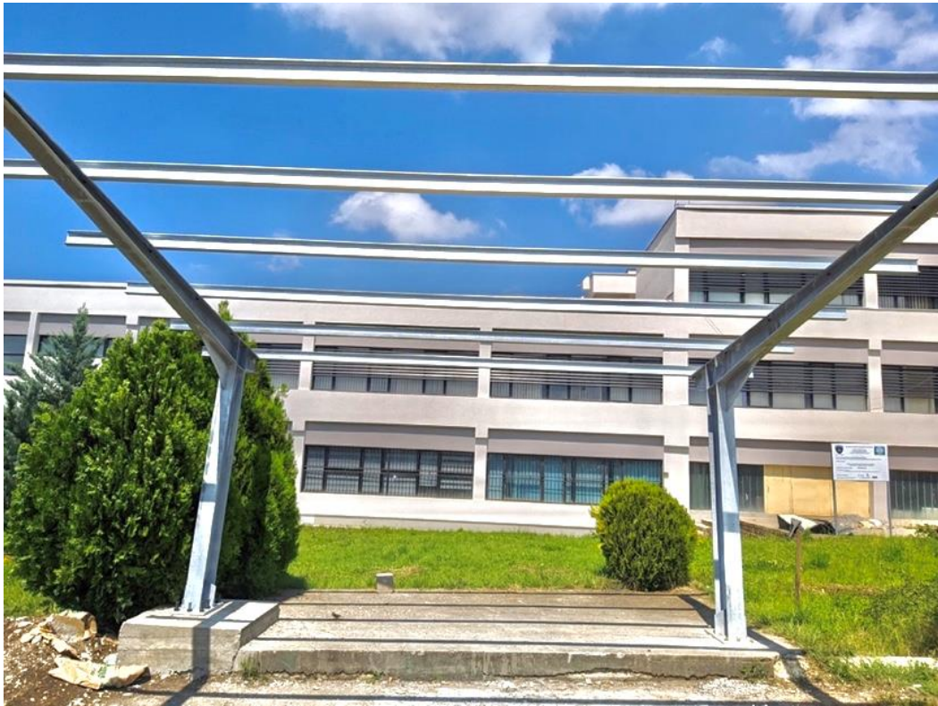
Figura 38. Vendosja dhe fiksimi i konstruksionit metalik.
