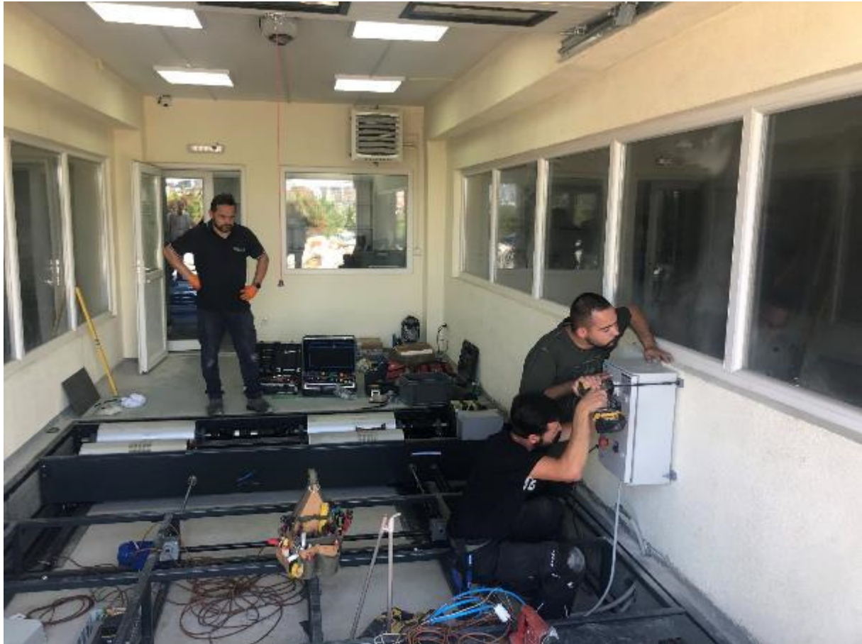
Figura 7.4: Gjatë instalimit të pajisjes testuese të fuqisë së motorit në FIM nga Bapro, Itali
