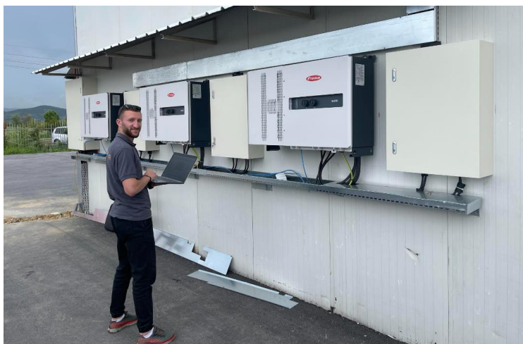
Fig.28 Konfigurimi i sistemit për fillim të prodhimit ([17])
