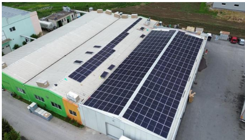
Fig.24 Pamja e paneleve solare gjate vendosjes ne objektiet e kompanisë ([17])
