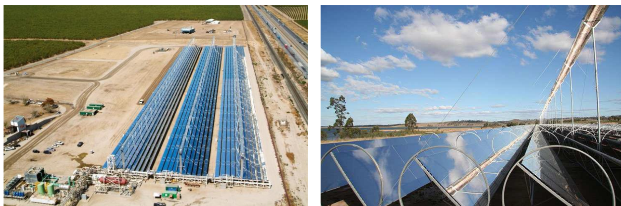
Figura 5.8 Pamje e një termocentrali me pasqyra Fresnel me një sistem monitorimi të lëvizjes diellore.
