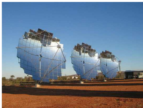
a) Pasqyra parabolike me absorbues dhe fokus në qendër të pasqyrës.
