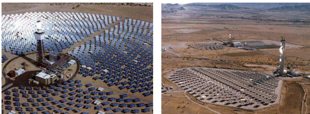
Figura 5.10 Pamja e një sistemi me përqendrimin e rrezeve të diellit në pikë me pasqyra të sheshta (helistate).
