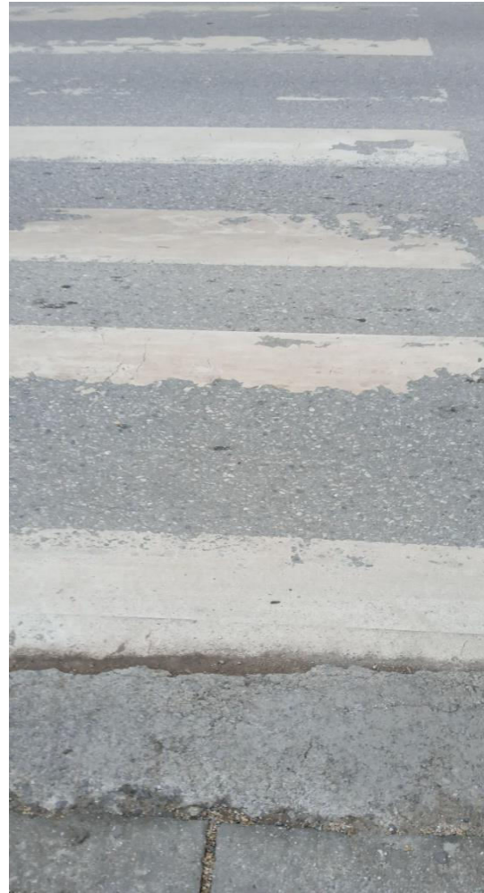
Figura 3.12: Afërsia e zhdukjes së gjurmëve dhe gjendja e vendkalimit të këmbësorëve
