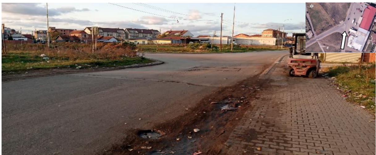
Figura 2.45: Fotografimi i udhëkryqit përgjatë rrugës “Vëllezërit Gërvalla” në drejtimin Jug-Veri
