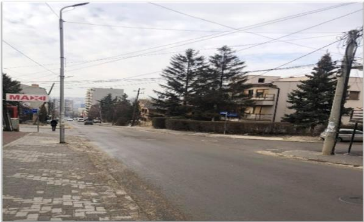
Figura 4.9: Mungesa e sinjalizimit horizontal përgjatë segmentit rrugor
